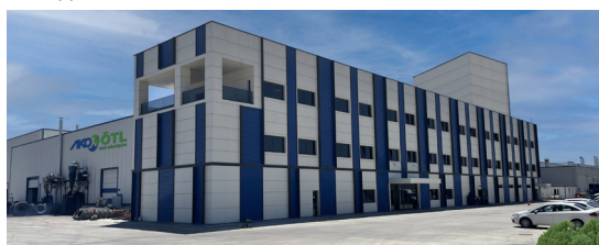
Завод по восстановлению шин
